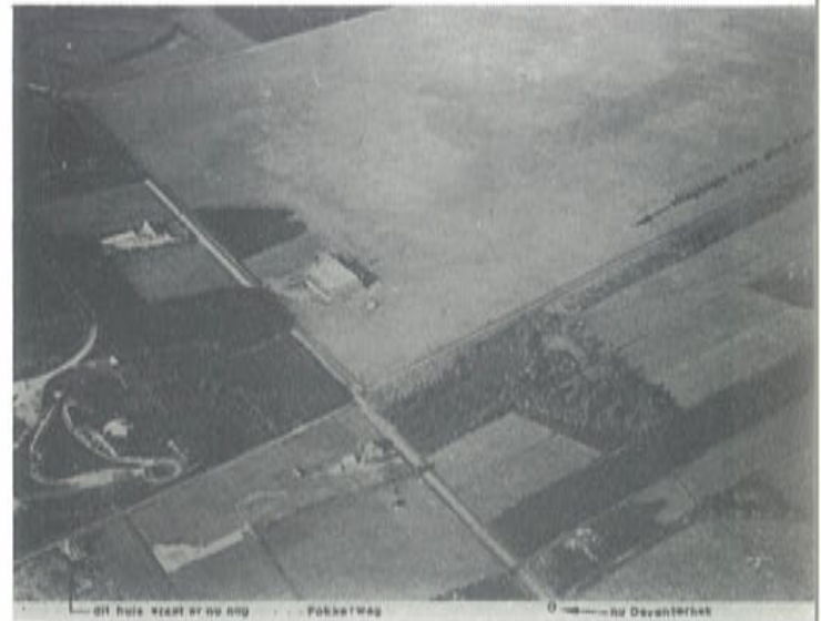
Vliegveld Twente in de tweede helft van de dertiger jaren. Ten oosten van de hangar valt nog het clubhuis van de TZC te ontwaren.
